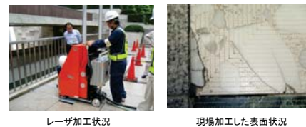
図8 現場の加工状況
